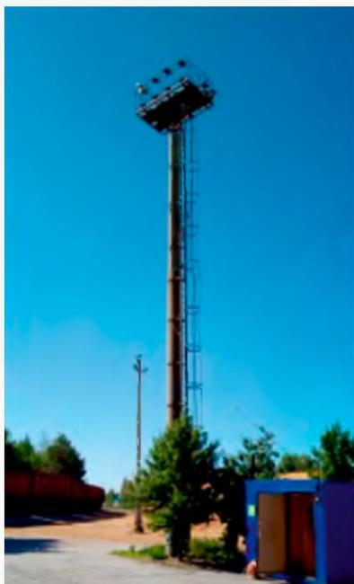
Пример решения задачи по освещению железнодорожной станции погрузки древесной щепы с мачты высотой 25 м.
